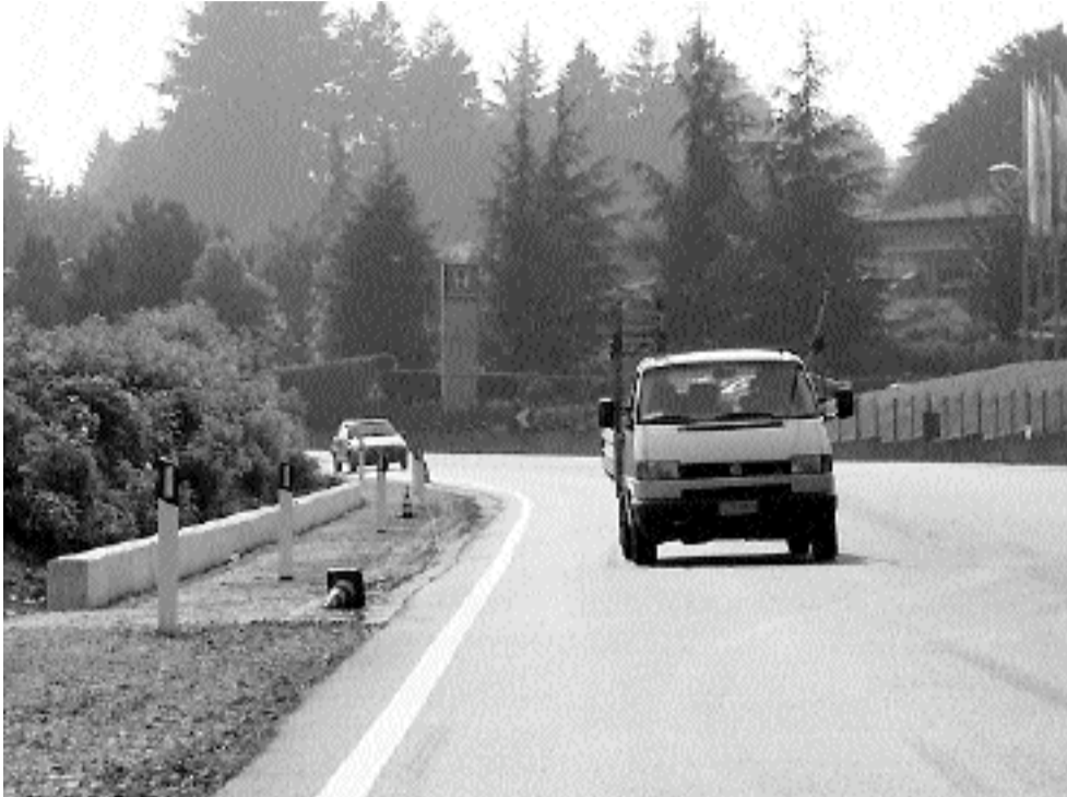
LA CURVA NEL MIRINO l'asfalto è stato rifatto, ma senza rettificare il raggio della svolta [foto Bartesaghi]
